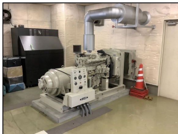
【発電設備 撤去・新設】
