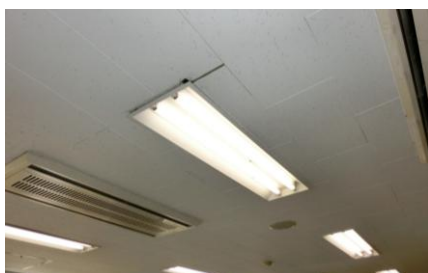
現況（庁舎執務室天井）
