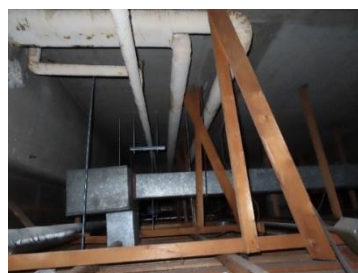
撤去箇所（庁舎天井木下地）
