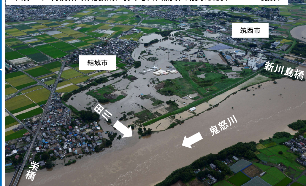
平成27年9月関東・東北豪雨における田川流域の浸水状況(H27.9.10 撮影)
