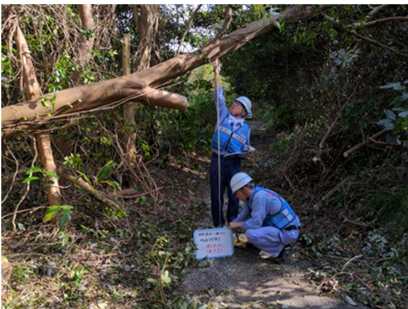
被災状況調査
