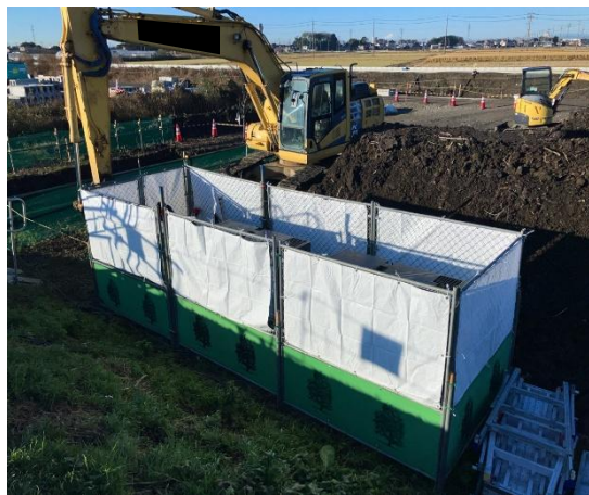
発電機の周囲に目隠しフェンスを設置
