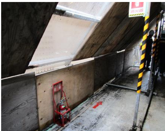
採光を確保し、足場内の視認性の向上
