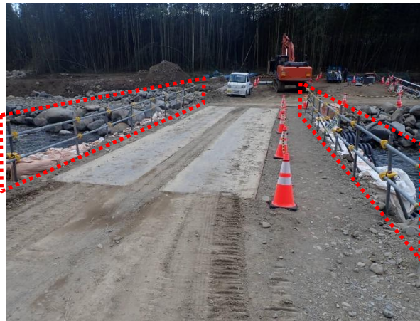
渡河部に落下防止柵を設置
