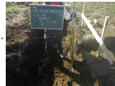
【試掘による確認】
