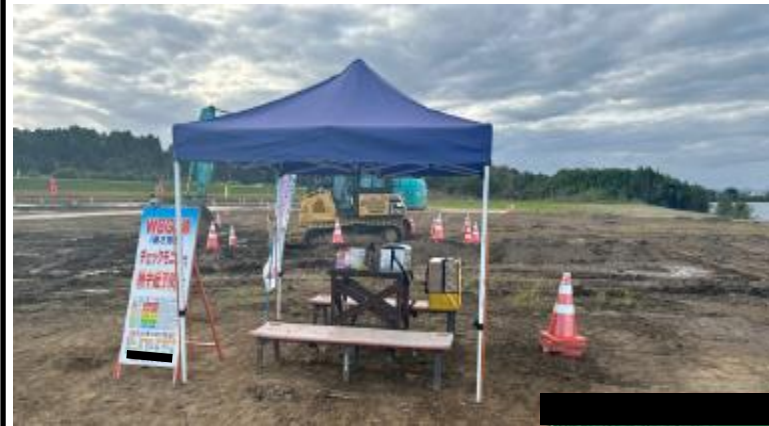
近傍に遮蔽物がない現場へ休憩 TENT、飲料等を設置
