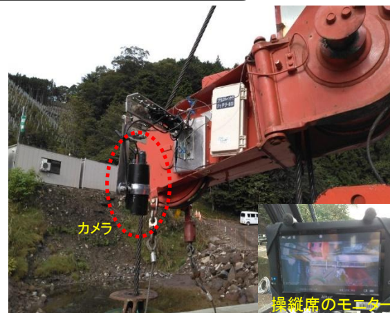
クレーン操縦席からの死角を、操縦席モニターで確認可能
