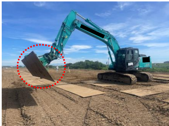
マグネット式アタッチメントによる鉄板敷作業の省人化
