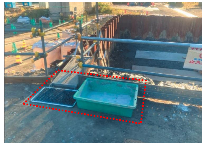
付着した泥による転倒防止のため、 洗い場、泥落としマットを設置
