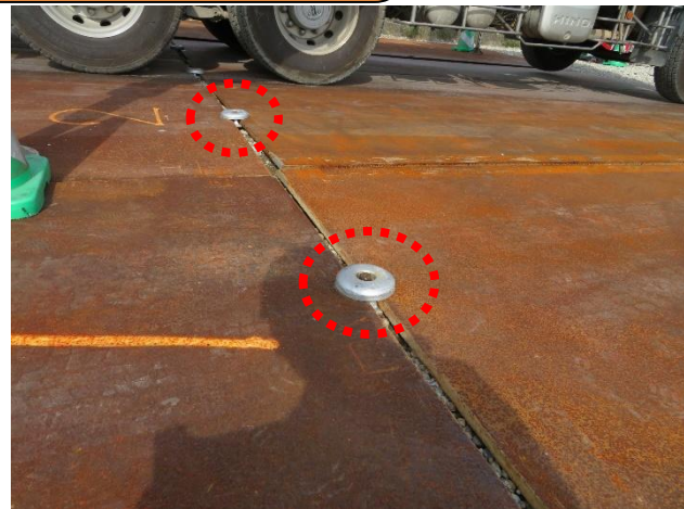
敷鉄板同士に専用のリングプレートを設置し、盗難防止、ずれ防止
