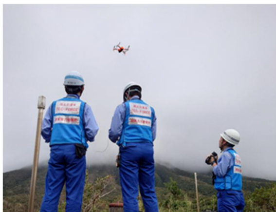
ドローンによる被災状況調査
