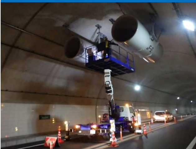
トンネル換気設備点検作業
