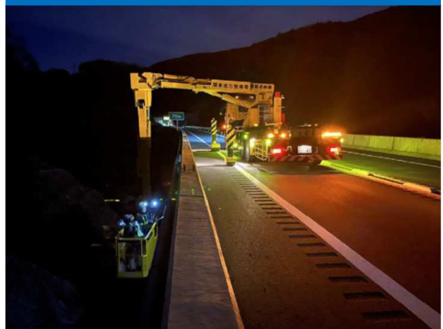
橋梁点検作業
