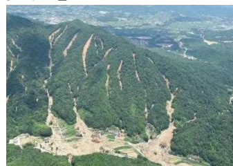
同時多発的な表層崩壊や土石流
