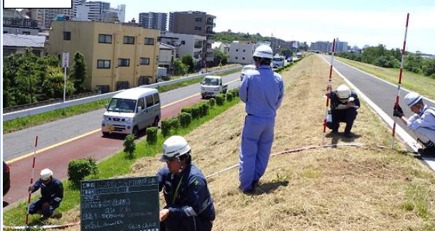
テープによる変化点毎の法長計測
