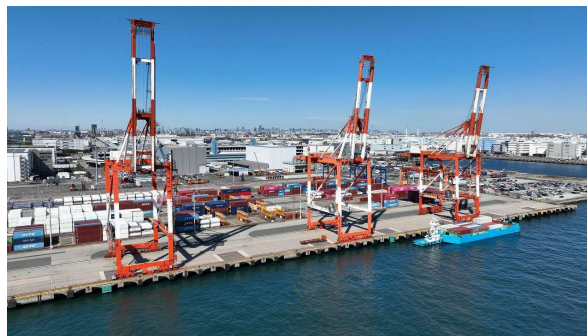
CO2フリー電力で動くインバータ方式のガントリークレーン 令和4年から港内使用電力のCO2フリー化を実施
