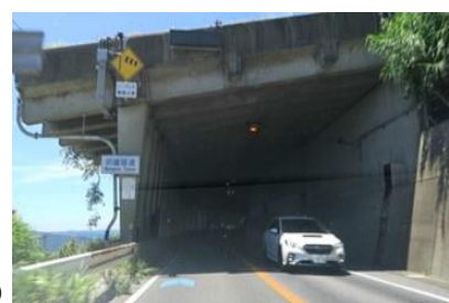
明鐘第一ロックシェッド
