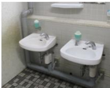
本館棟1階便所
