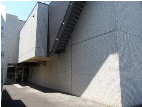
流水管理棟 全景
