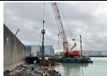
本体工(高剛性壁体打設)施工状況
