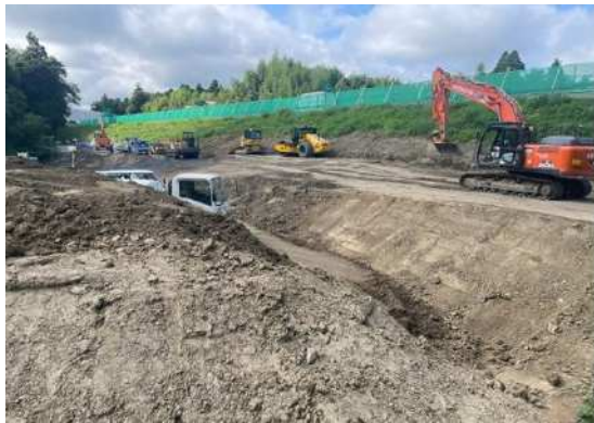
盛土施工状況
