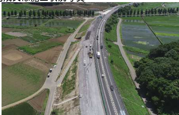
盛土施工状況
