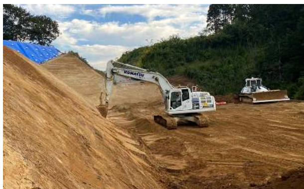
掘削施工状況
