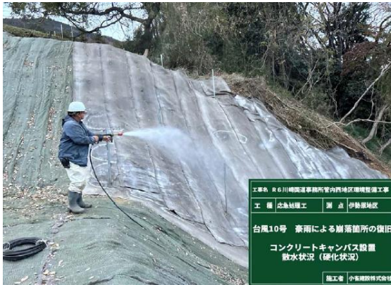
【コンクリートキャンバスへの散水】
