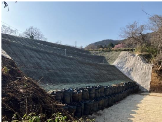
【崩落箇所復旧状況】
