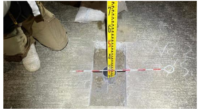
【プレートくいの敷設】
