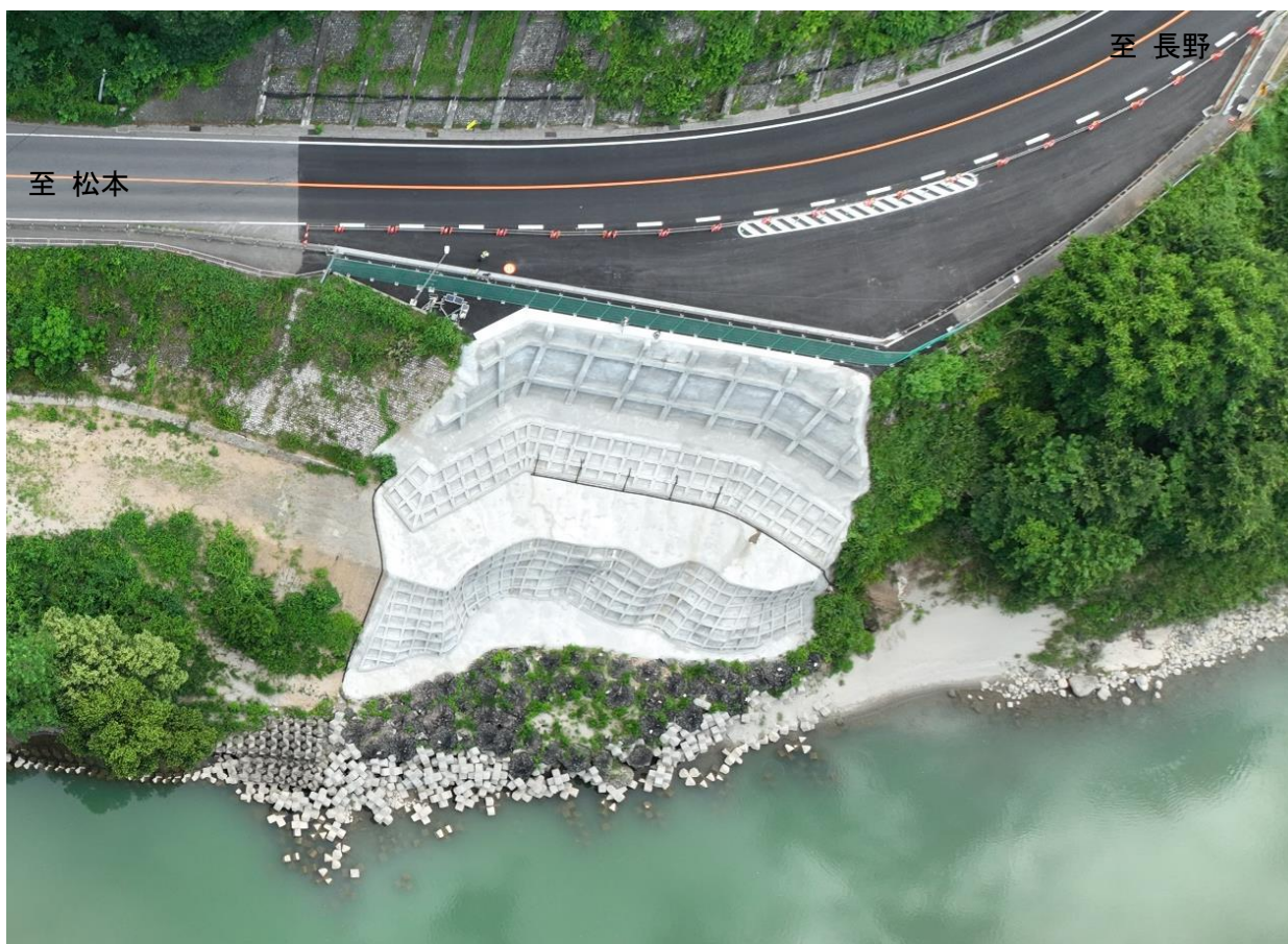
恒久対策完了状況：令和7年7月14日撮影
