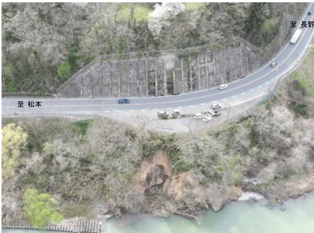
被災時の状況：令和6年4月15日撮影
