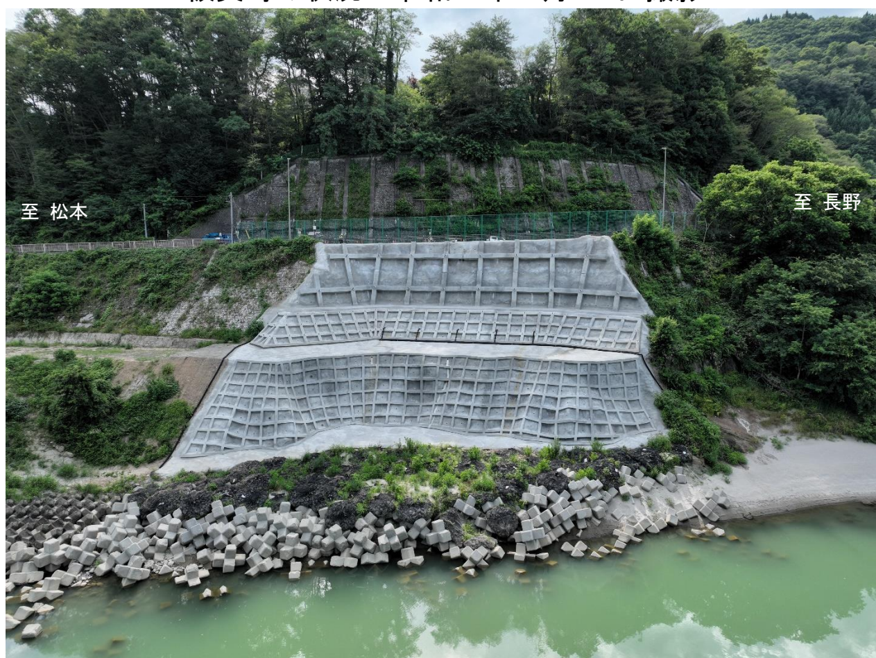
恒久対策完了状況：令和7年7月14日撮影
