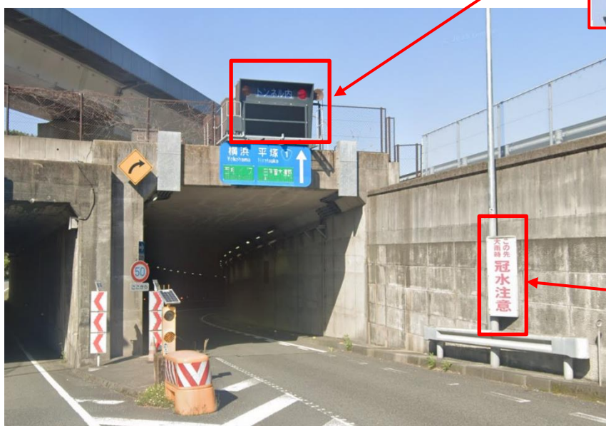
アンダーパス部の例【道路冠水箇所リスト No116】
