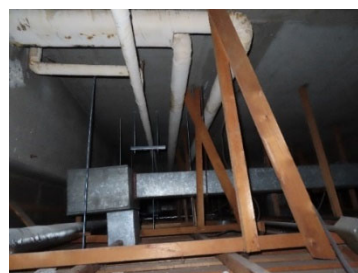
撤去箇所（庁舎天井木下地）
