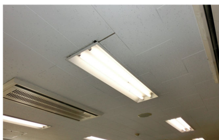
現況（庁舎執務室天井）
