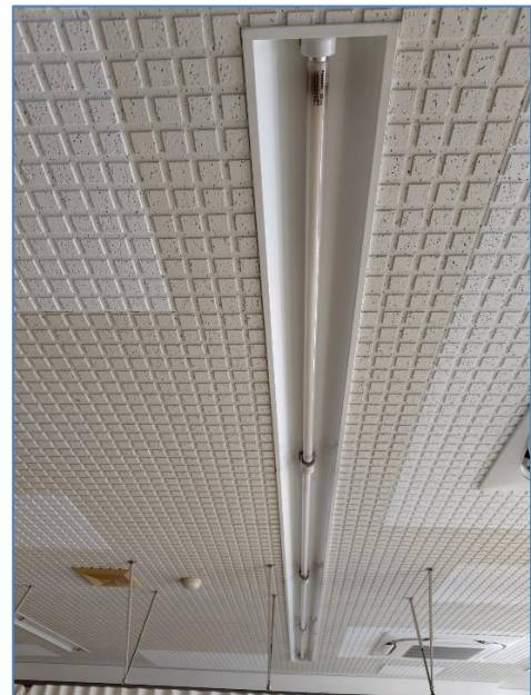
1 F 会議室天井
