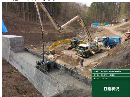
本体コンクリート打設状況
