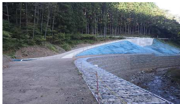
完成：黒川第二砂防堰堤の管理用道路
