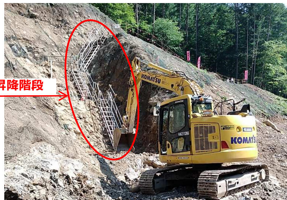
左岸法肩部の掘削 実際の施工
