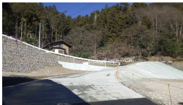
完成：万場地区砂防堰堤群の工事用道路
