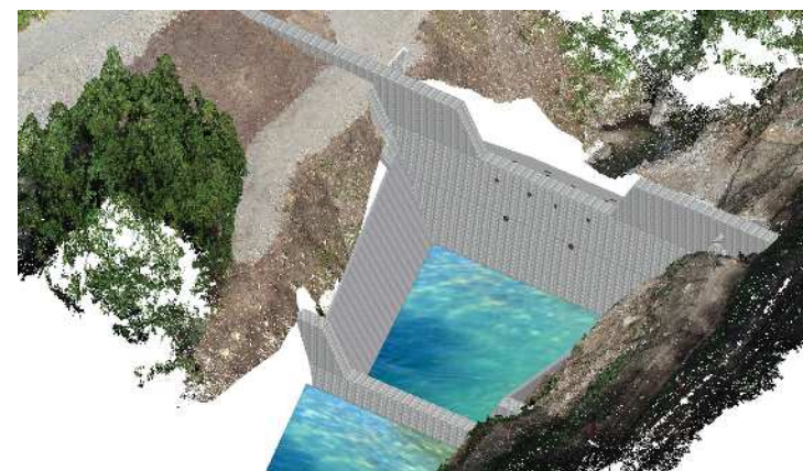
砂防堰堤全体の完成形画像
