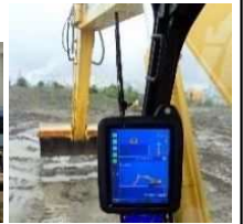
ICT建設機械の施工
