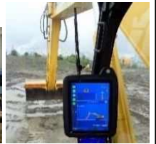
ICT建設機械の施工
