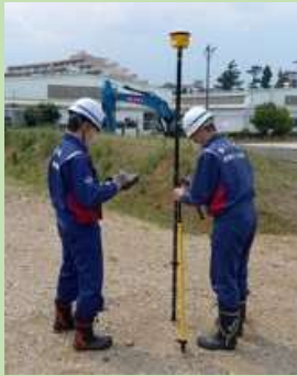
3次元計測機器による起工測量実習
