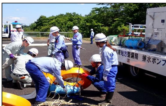
排水ポンプ組立訓練
