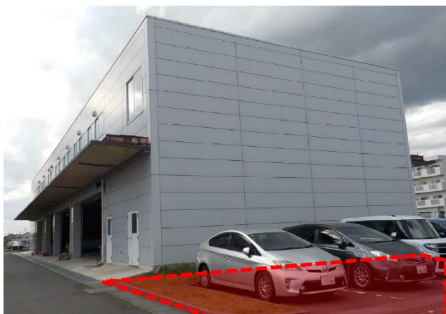
車庫（南東面） ※赤線部仮設事務所設置可能
