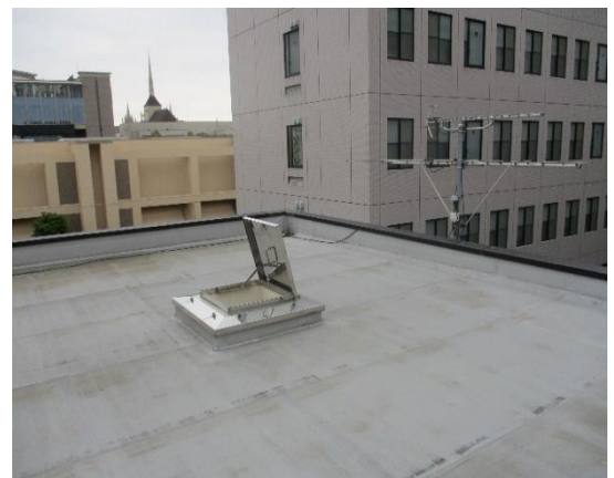
③ 屋上 点検口
