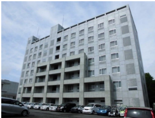
外観（西面外壁）
