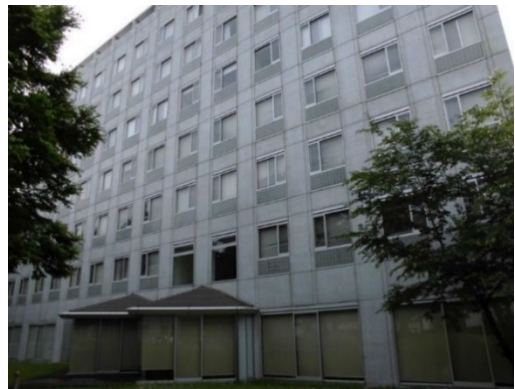
外観（東面外壁）
