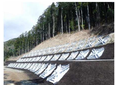
対策工(アンカー工)
