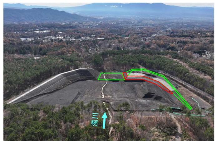
濁川第一砂防堰堤（施工中）
