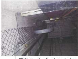
既存エレベーターシャフト内3
