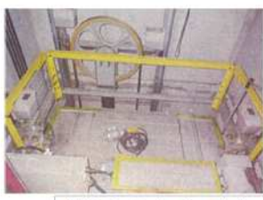
既存エレベーターシャフト内2
