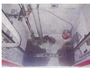
既存エレベーターシャフト内1
