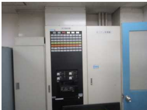
図1 事務庁舎棟（受信機）
