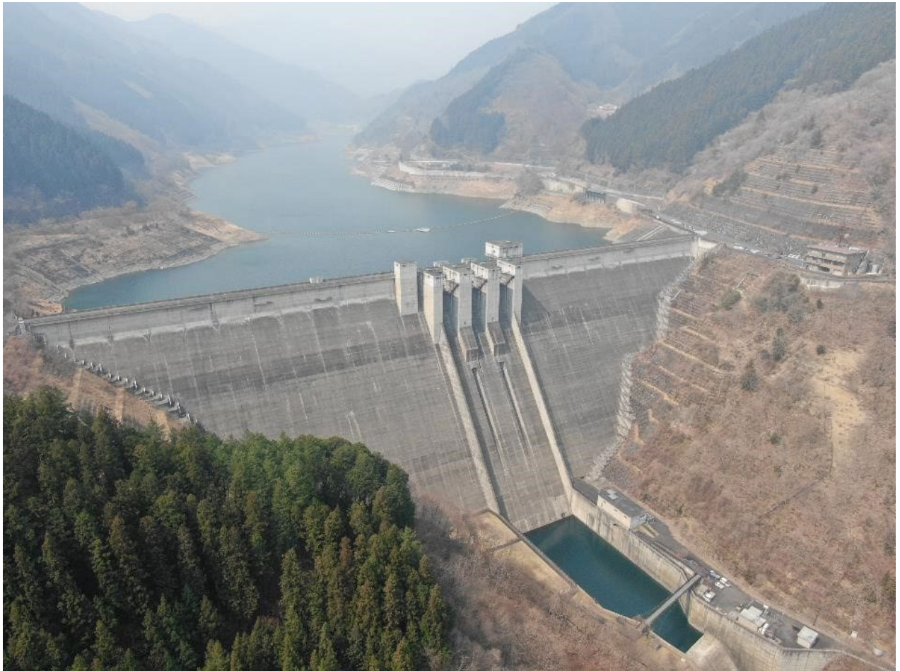
滝沢ダムと奥秩父もみじ湖(令和7年4月22日撮影)
