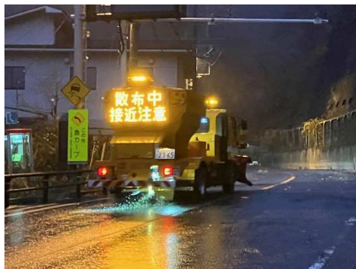
凍結防止剤散布状況
