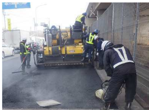
舗装補修状況
