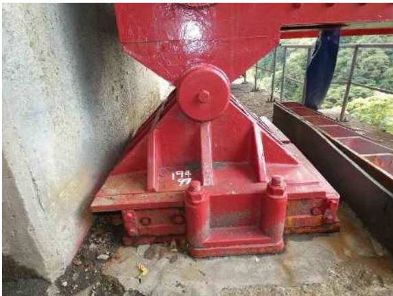
— 新三国大橋（支承補修） —
