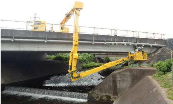
橋梁点検車による点検状況（柳瀬川橋（上り））
