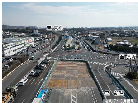
② 渋川市中村の橋梁下部工事施工状況
