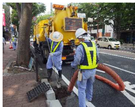
道路清掃状況
