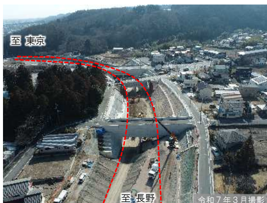
① 渋川市渋川の改良工事施工状況
