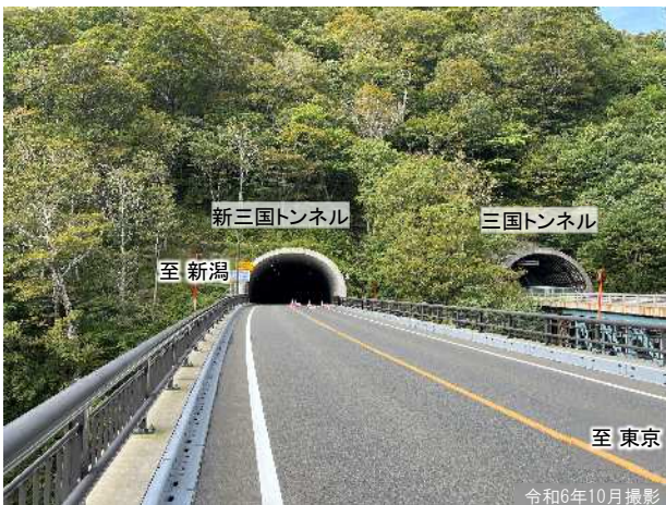
①新三国トンネルの状況
