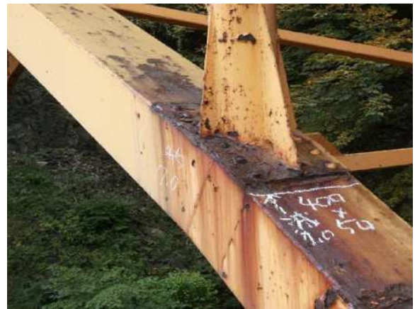
— 法師大橋（アーチ部補修） —
