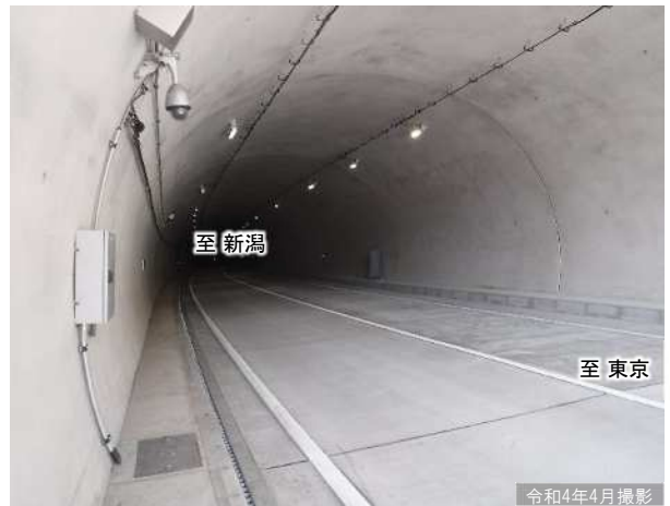
②新三国トンネル内部の状況
