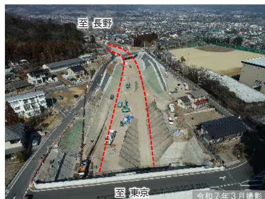
② 渋川市金井の改良工事施工状況
