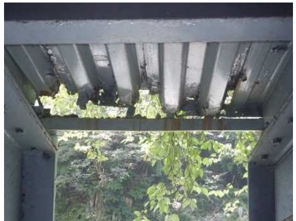
— 渋川上白井綾戸（横梁部補修） —
