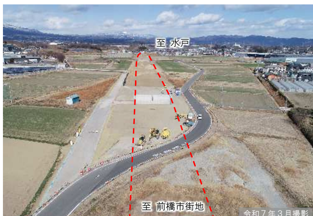
①伊勢崎市赤堀今井町の改良工事施工状況
