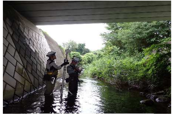
点検ロボットカメラを活用した 橋梁点検状況（藤沢川橋（上り））
