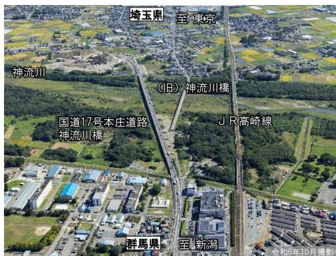
神流川橋付近の状況
