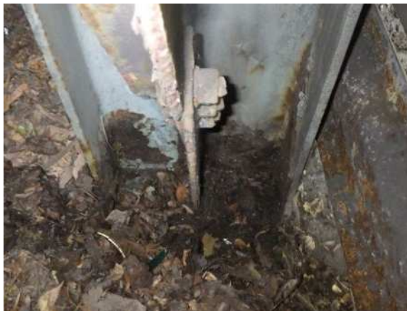
— 渋川上白井綾戸（柱基部補修） —
