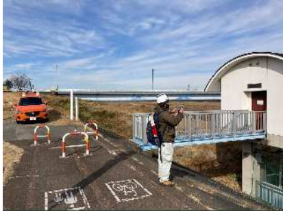
からすがわ 烏川右岸4.4k付近
