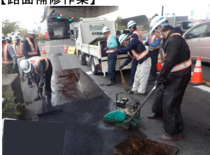
【路面補修作業】
