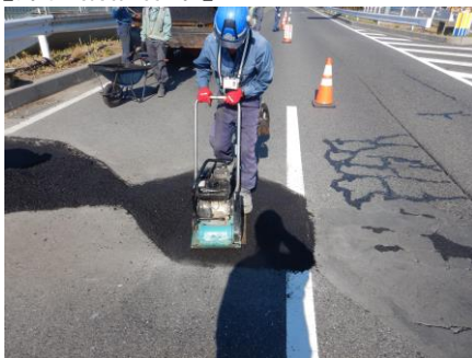
【路面補修作業】
