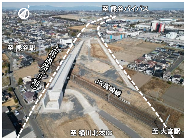
【箕田地区の施工状況】
