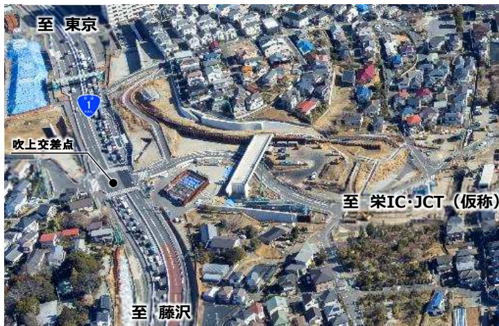
①【戸塚IC(仮称)付近状況(令和7年3月撮影)】
