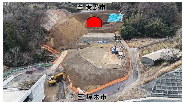
②【伊勢原第一トンネル工事(令和7年2月撮影)】
