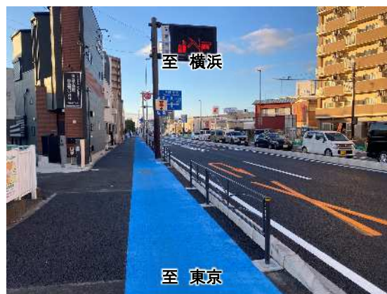
【歩道整備後の状況】 (歩道拡幅による歩行者と自転車走行空間の分離) (川崎市幸区神明町下り線)
