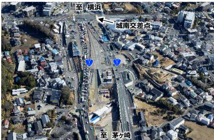
①【藤沢IC付近状況(令和7年3月撮影)】
