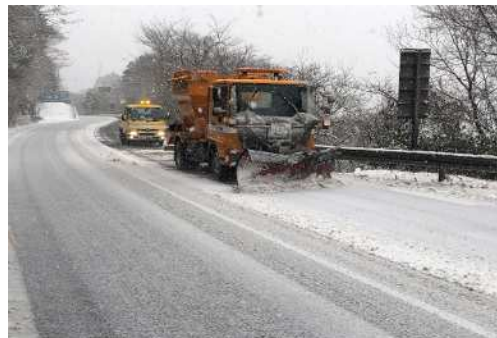
除雪作業 (国道1号箱根新道)
