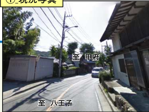
① 現況写真
