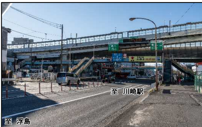
①現在の大師河原横断歩道橋(浮島から川崎駅方面)
