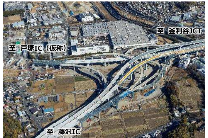
②【栄IC・JCT(仮称)付近状況(令和7年3月撮影)】
