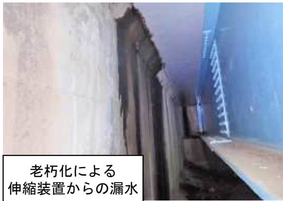
橋梁補修 施工前
