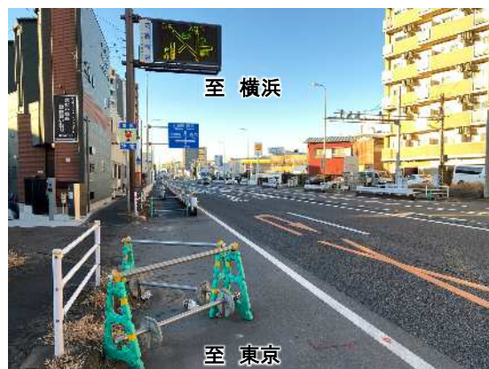
【歩道整備前の状況】 (川崎市幸区神明町下り線)
