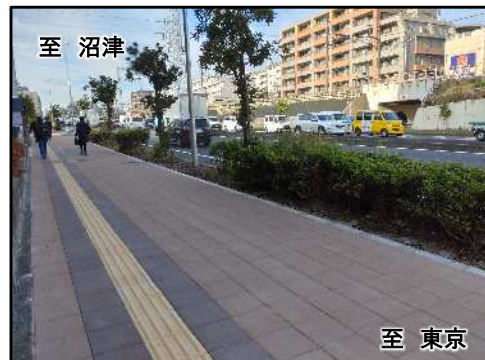
②整備後の市ヶ尾地区(拡幅部)
