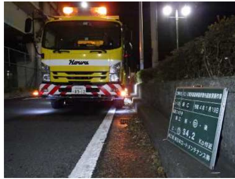
清掃 (路面清掃・排水施設清掃等)
