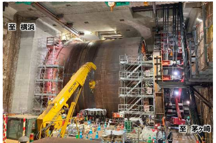
②【トンネル工事状況(令和7年3月撮影)】
