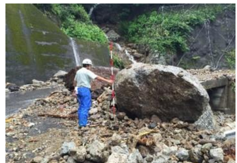
② 落石状況(平成27年9月)
