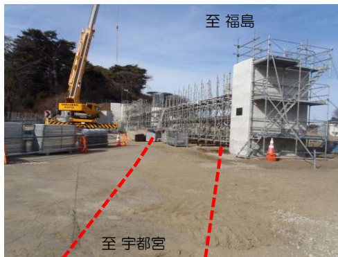
② 烏ヶ森横断歩道橋の施工状況
