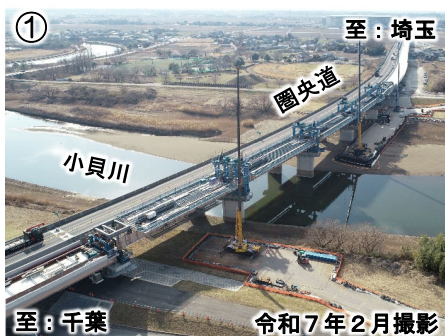
① 至：埼玉 常総IC～つくば中央IC(小貝川橋付近) 令和7年2月撮影
