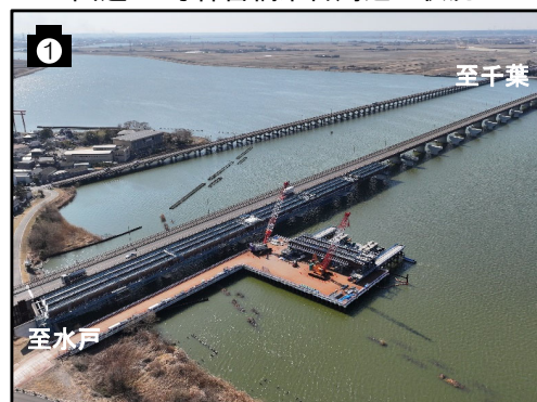
橋梁上部工の施工状況（令和7年2月撮影）
