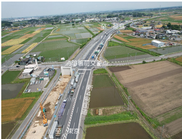
①元栗橋跨道橋（消防署前交差点）付近
