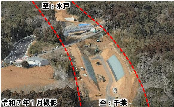
なめがた りょうしゆく 行方市両宿地区 改良工事
