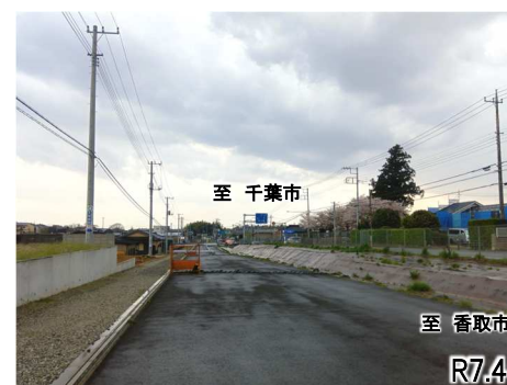
大栄拡幅(所交差点付近の改良工事)
