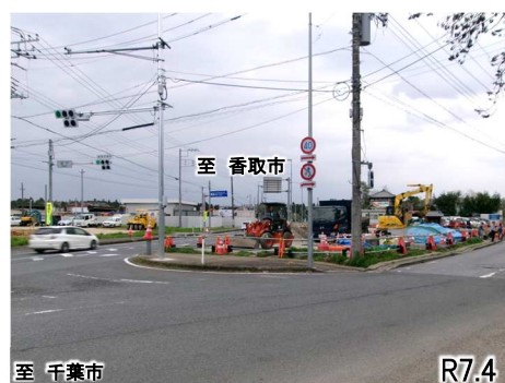
北千葉拡幅(坂戸交差点の改良工事)
