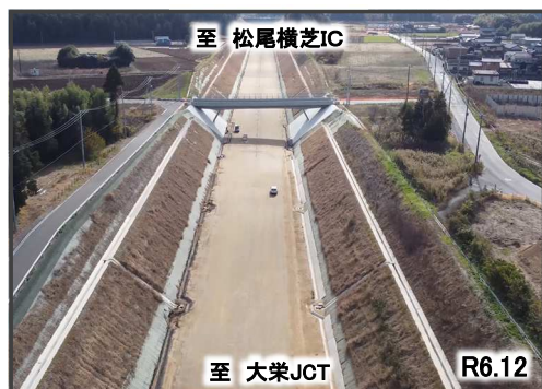
写真① 多古地区改良工事
