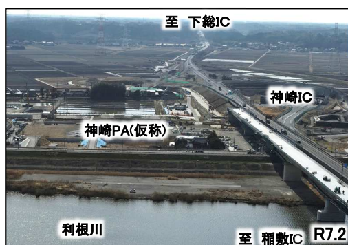
写真② 神崎PA(仮称)工事
