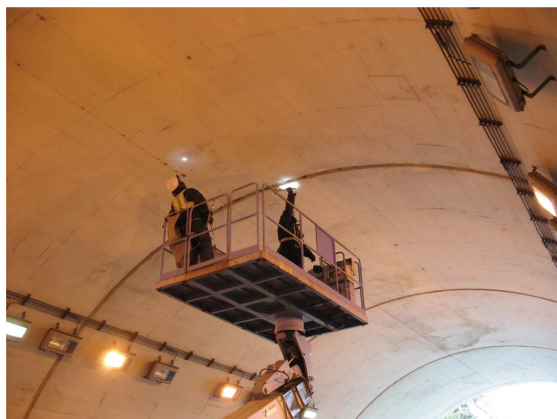
トンネル点検の様子
