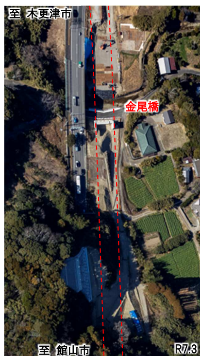
工事の実施状況(川名富浦地区)
