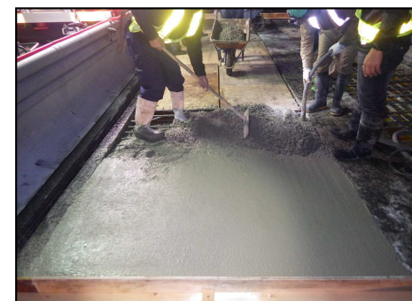
▲床版架替状況 (コンクリート打設)
