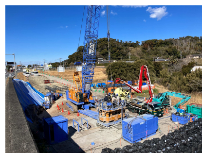
(場所打ち杭 施工状況)
