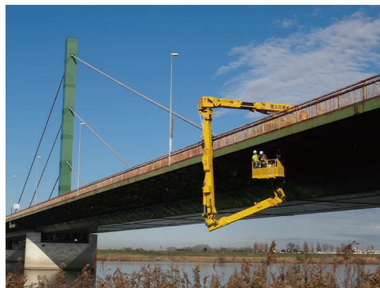
橋梁点検の様子
