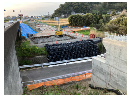
(場所打ち杭 施工完了)
