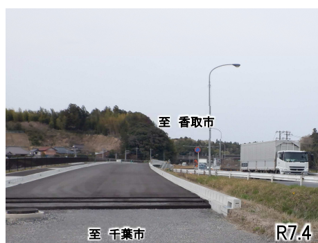
成田拡幅(東金山橋付近の改良工事)
