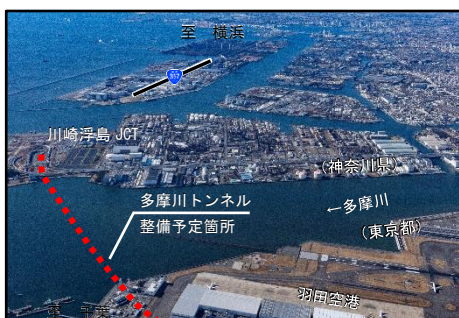
①多摩川トンネル予定地付近（令和6年1月撮影）
