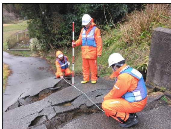
石川県輪島市
