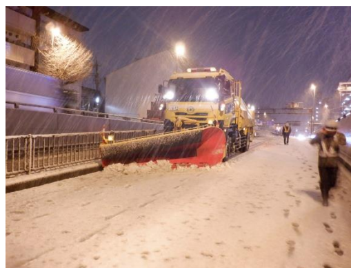
除雪作業（国道246号世田谷区瀬田）
