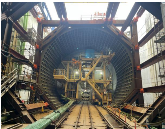
東名 JCT A ランプシールドトンネルの工事状況
