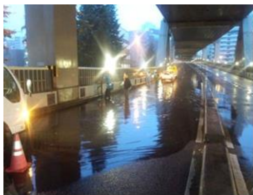
災害時の応急復旧（冠水処理）
