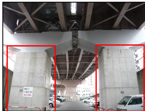
コンクリート巻立による橋脚補強
