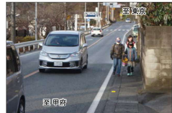
③ 現在の国道20号の状況
