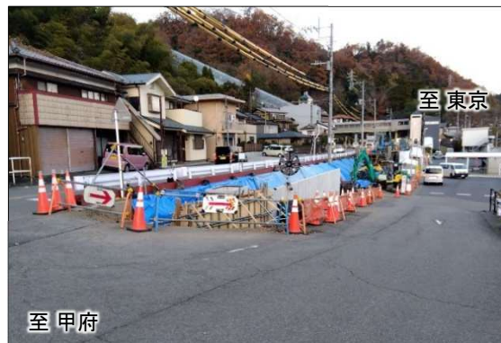
② 施工状況(全景)
