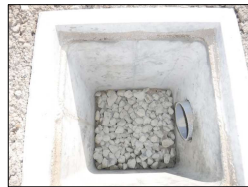
雨水貯留浸透槽整備事例(昭和町)
