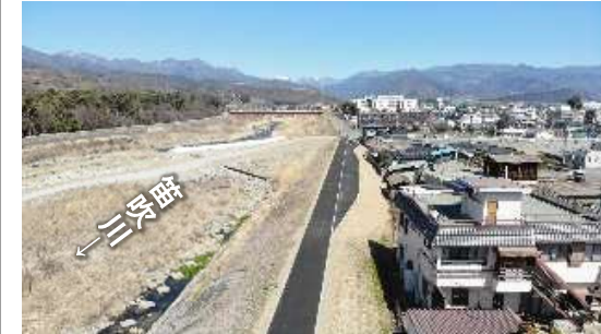
管理用通路の状況
