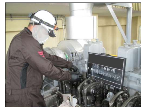
機械設備の点検
