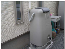
貯留槽の整備事例(富士市)
