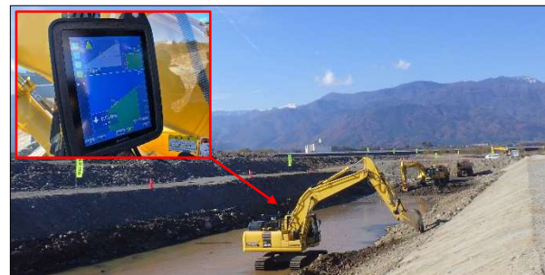
ICT建設機械による掘削（釜無川）
