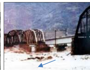
東海道本線鉄橋の流失
