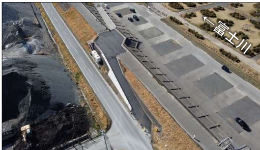
坂路改良の状況
