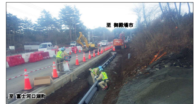
② 工事状況
