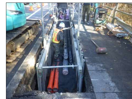
施工状況(鳴沢電線共同溝)
