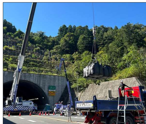
応急復旧工事の状況
