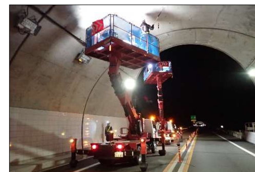
トンネル点検
