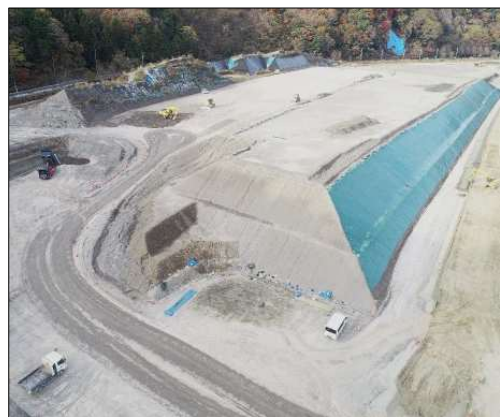
トンネル残土造成工事（粟倉地区）
