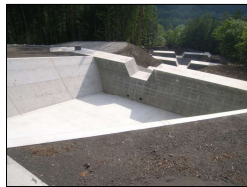
塩島沢堰堤群(富士川砂防事務所)
