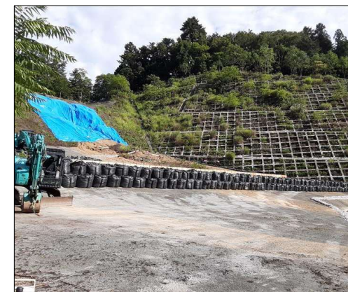
応急復旧工事後（現状）
