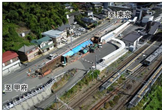
① 施工状況(全景)
