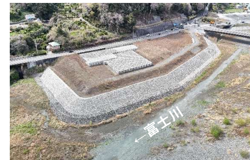
資材備蓄状況(R7.4)
