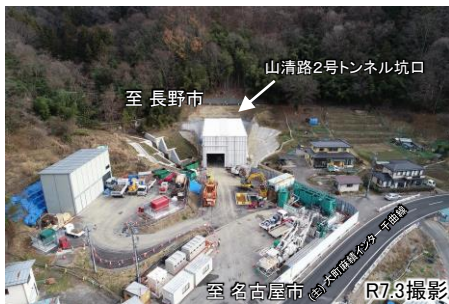
生坂村東広津地区の工事状況
