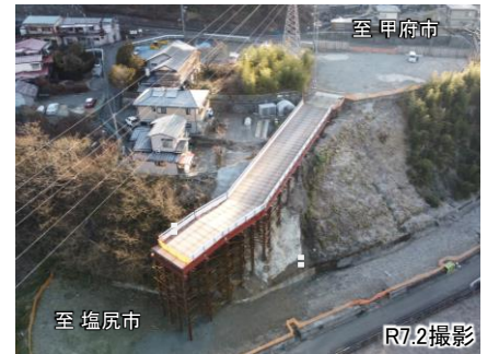
東町地区における橋梁下部工事の状況 R7.2撮影
