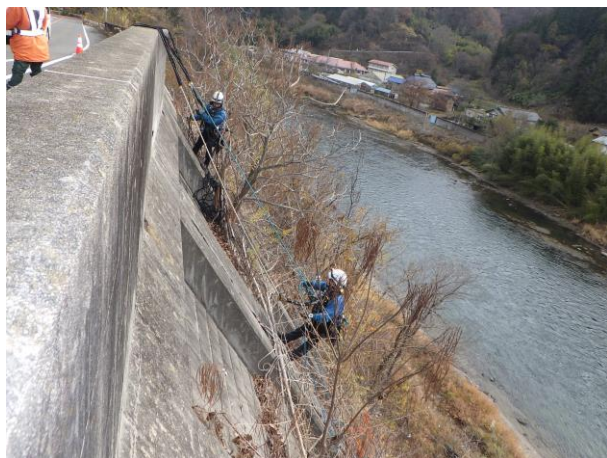
おおまちしやさか 国道19号大町市八坂地内点検状況
