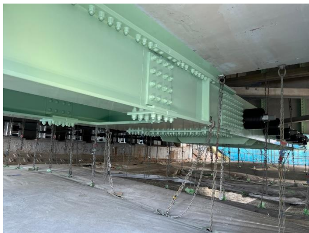
ながの 国道18号長野大橋補修状況
