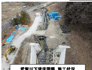
武智川下流床固群 施工状況
