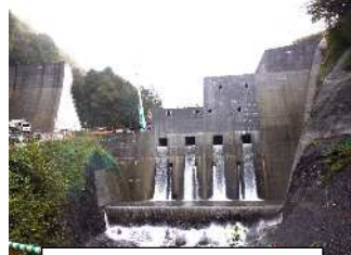
内河内第五砂防堰堤 施工状況
