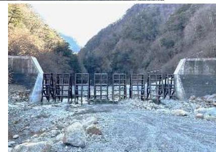
さぼうえんてい(とうかがわ) のろがわだいさんさぼうえんてい 砂防堰堤(透過型)：野呂川第三砂防堰堤
