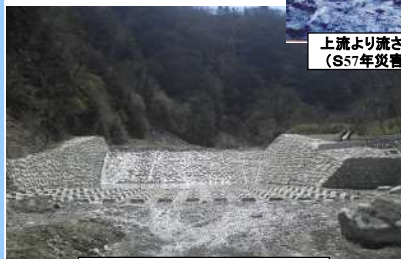
小武川下流床固群 施工完了箇所
