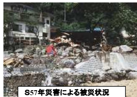
S57年災害による被災状況 (武智鉾・釜無川合流部)
