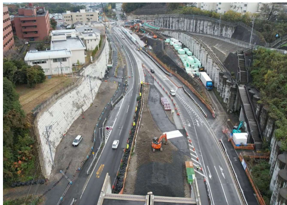
○医療センター周辺道路切替え前
