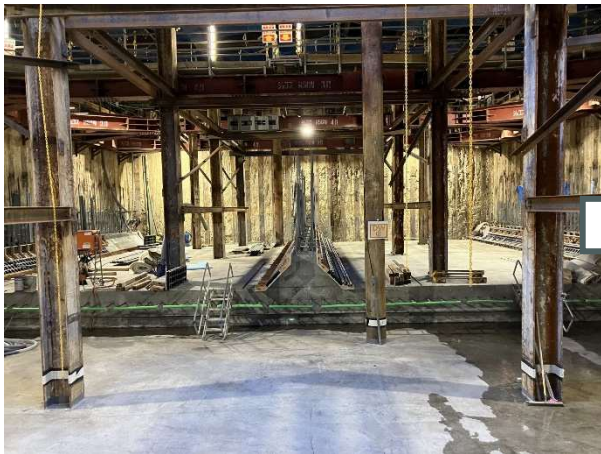
○函渠工＜底版Co打設＞
