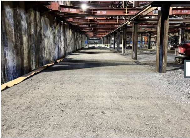
○掘削、砕石敷き均し完了
