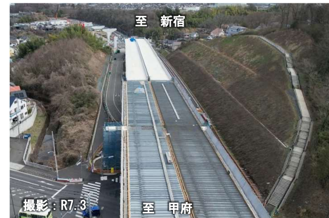
写真③ 大船寺田高架橋 状況
