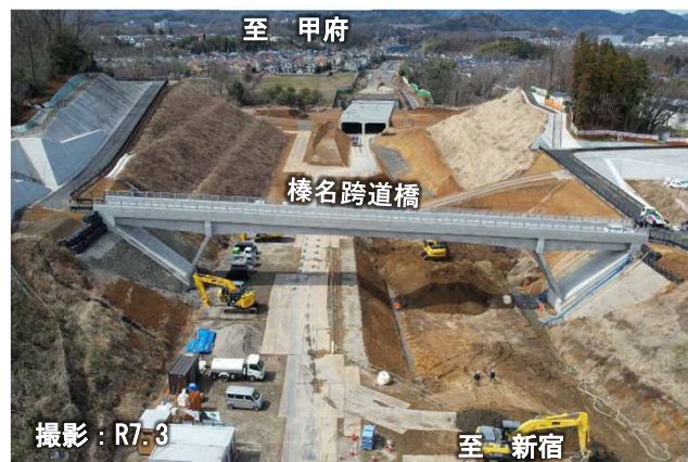
写真② 寺田地区改良工 状況
