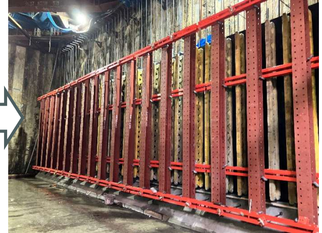
○函渠工＜側壁部型枠組立＞
