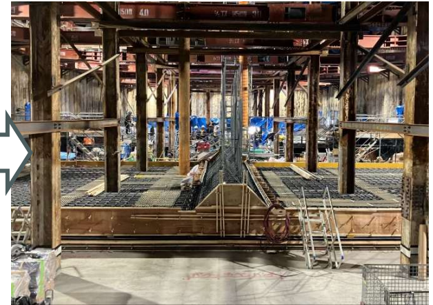
○函渠工＜底盤Co鉄筋組立＞
