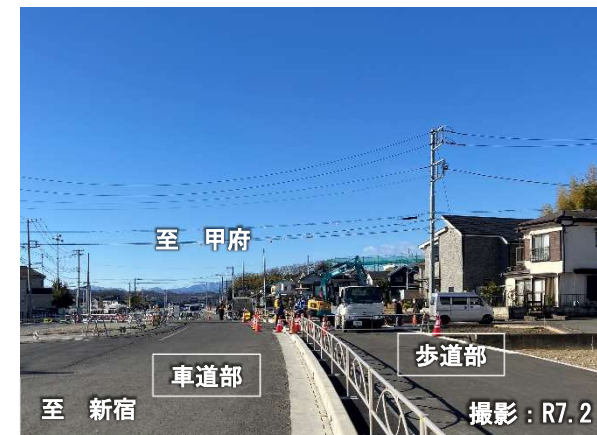
写真② 川辺堀之内地区改良工
