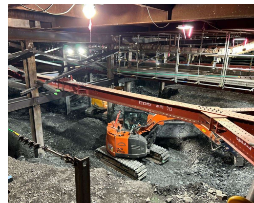
○下り線 覆工下掘削状況
