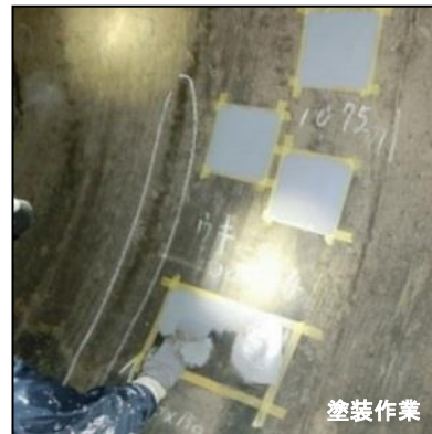
導水管内補修状況
