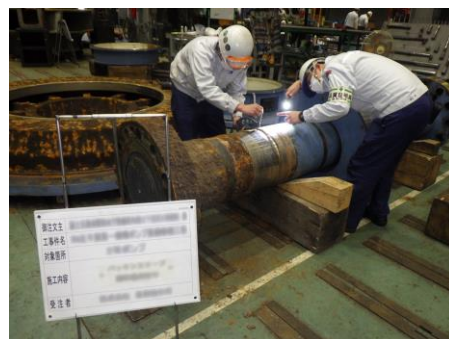
主ポンプ分解補修状況
