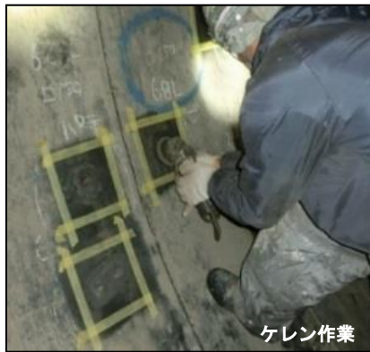
導水管内補修状況
