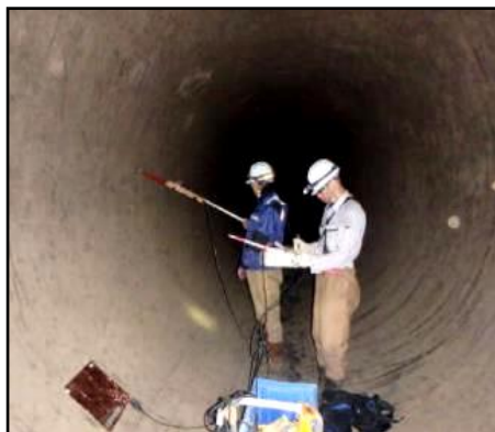
導水管内点検状況
