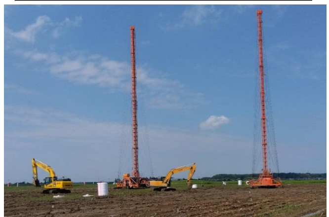
甘田入地区基盤整備工事
