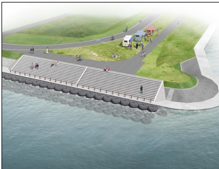
田村地区（土浦市）緩傾斜・階段護岸整備イメージ図 (令和6年度繰越予算：令和7年度施工予定)
