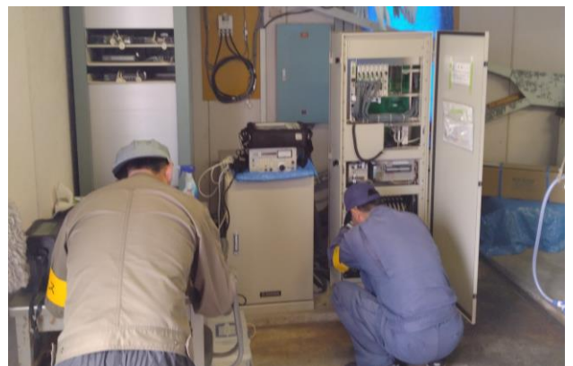
電気設備点検状況
