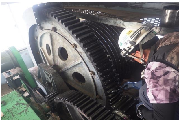
機械設備点検状況
