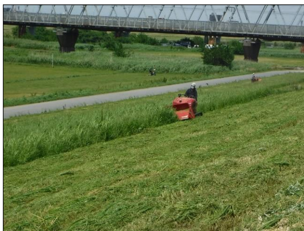
堤防除草 (堤防の異常を発見しやすくするため)
