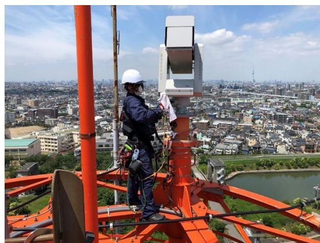
電気・通信設備の点検・整備
