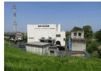
菊沢川排水機場制御設備修繕
