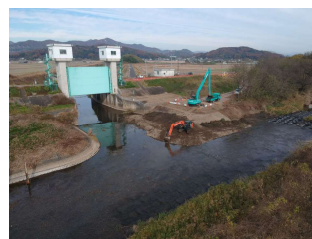
【管内全域】維持管理(例) 水門水路の土砂等撤去作業
