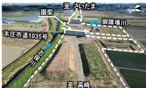
📷 上里町神保原付近の工事状況
