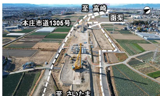
📷 本庄市沼和田付近の工事状況
