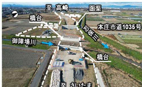
📷 上里町神保原付近の工事状況
