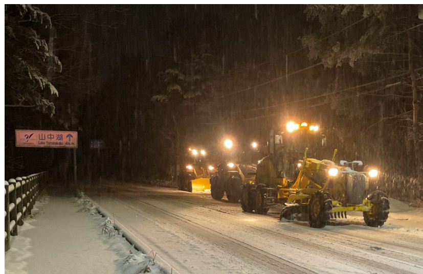
(令和6年2月29日 国道138号 山梨県山中湖村)
