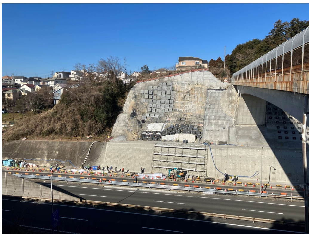
②災害復旧工事状況 令和7年2月28日撮影
